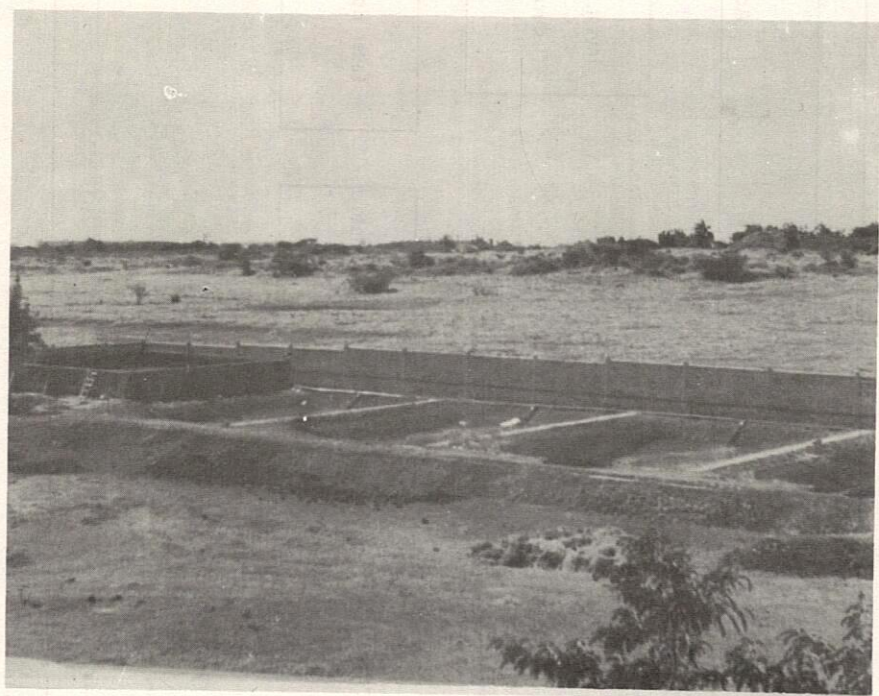
Figura 1. Estanques (charcas) del INDOTEC
